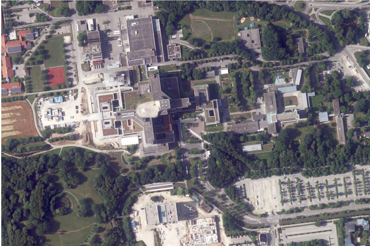
Bild 21: Luftbild zeigt Baustellenfläche westlich des Anbau West, CC BY 4.0, DOP40, geodaten.bayern.de/opengeodata , 08/2024
