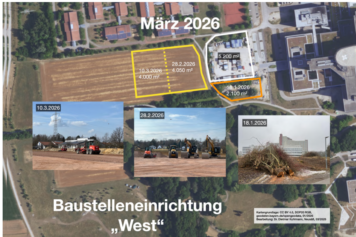
Bild 10: Zeitliche Entwicklung der Baustelleneinrichtung westlich des „Anbau West“
